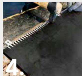
**4.** Battere con martello sui dentini della giunzione per fissarla al nastro.
